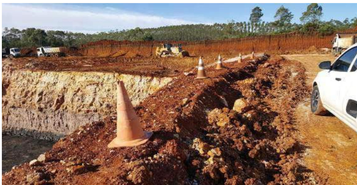
Figura 7: Remoção da camada argilo-arenosa de cobertura na Mina Santana Céu Aberto.
