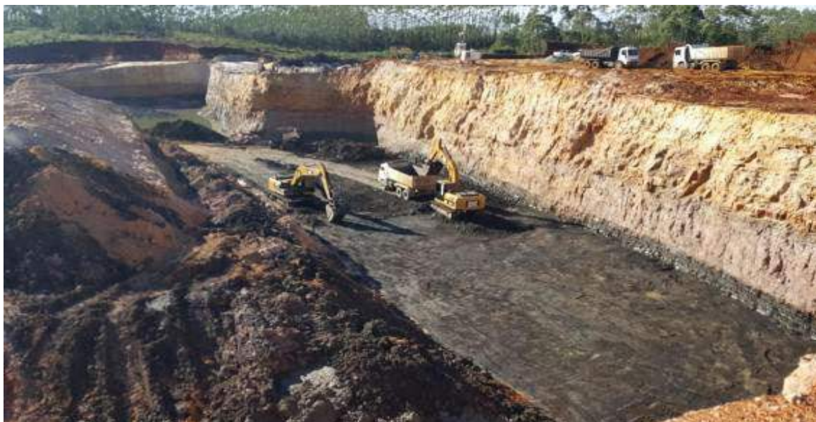
Figura 12: Desmonte mecânico e carregamento da camada de carvão em caminhões basculantes.
