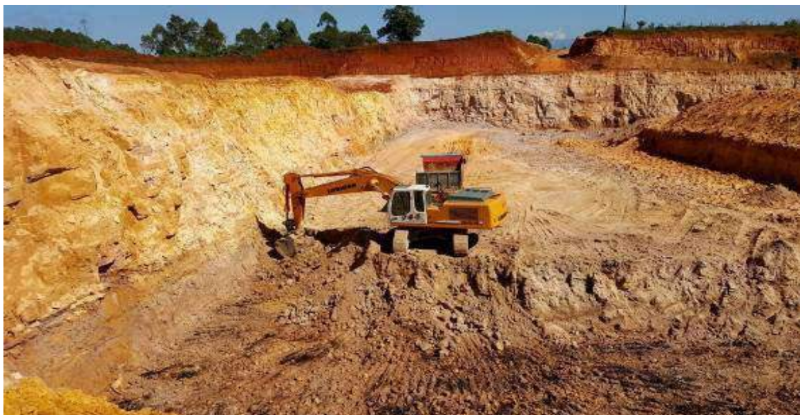
Figura 10: Remoção do banco de arenitos e do siltito de cobertura da camada de carvão Barro Branco.
