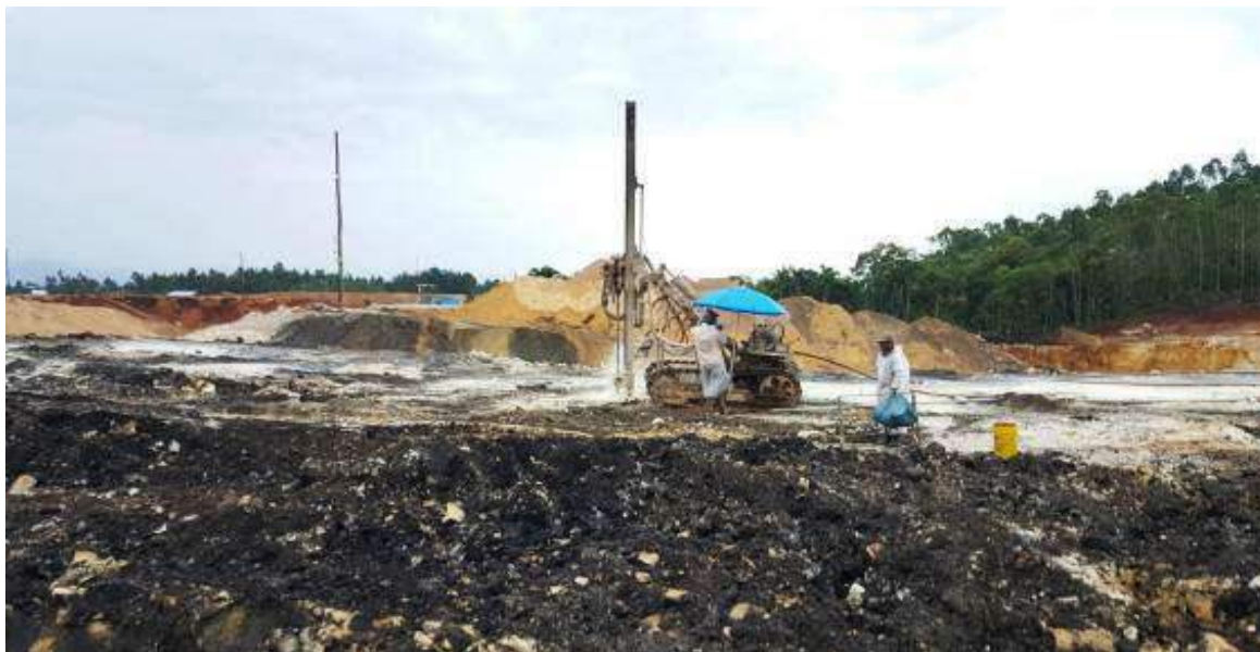
Figura 9: Perfuração do banco de arenitos de cobertura para desmonte com utilização de explosivos.
